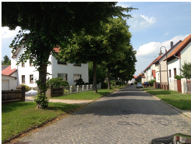
Abbildung 1: Triftstraße bestehende Situation – Blick Richtung Norden
